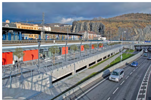
Obrázek 1 Pohled na objekt zanádraží a Přístavní ulici
