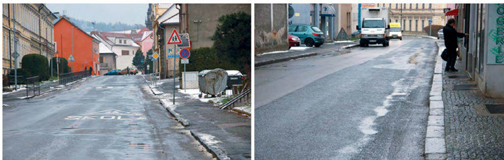
Obrázek 2 Fotodokumentace původního stavu komunikace Pražská
