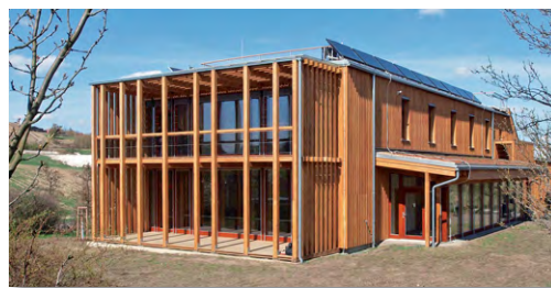
Obrázek 2 Nově vybudované Centrum ekologické výchovy Kladno
